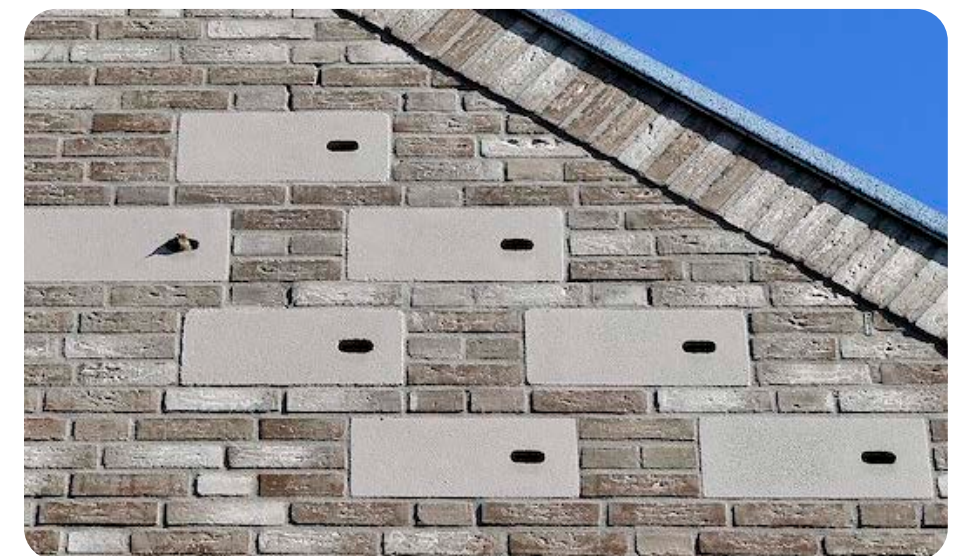
Toepassing ingebouwde nestkasten in kopgevels
