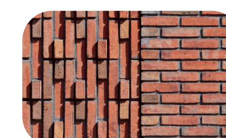
Detaillering in metselwerk
