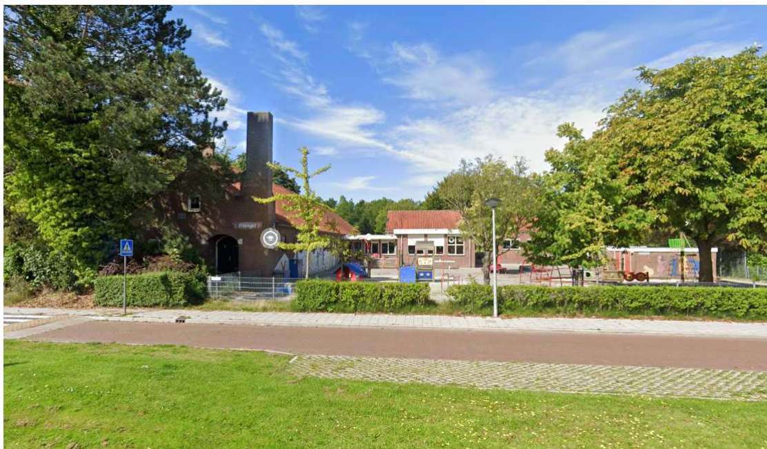
Figuur 2. Huidige situatie van de Openbare Basisschool De Triangel aan de Terpstraat 42 te Wieringerwerf.
