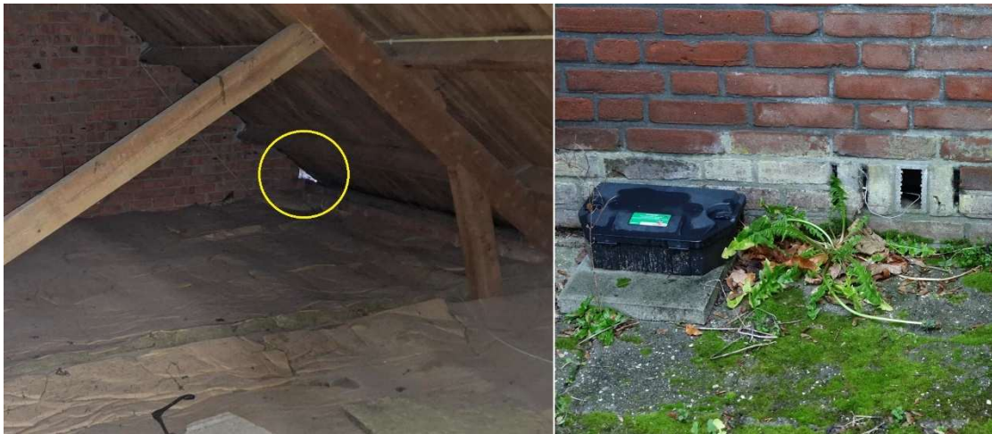
Figuur 5. Opening aan dakrand (gele cirkel links) en naar de kruipruimte in de gevel van de voormalige gymzaal.
