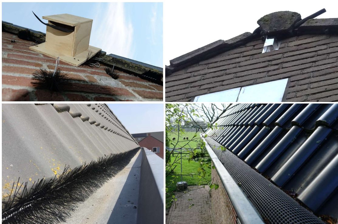
Figuur 10. Het natuurvrij maken van openingen en dakranden met behulp van weringsborstel, vulschuim, exclusionflaps en dakgootbeschermers.
