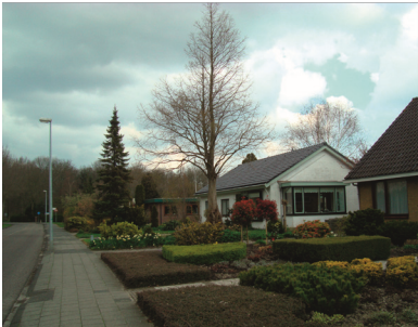
Vrijstaande woningen aan de Terpstraat
