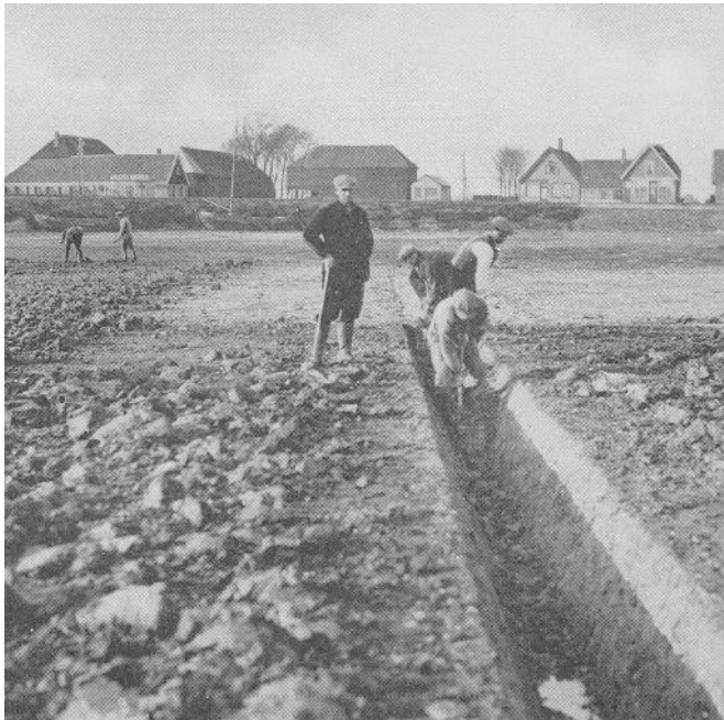
Greppels werden met de hand gegraven, 1930. [Directie Wieringermeer, 1955]
