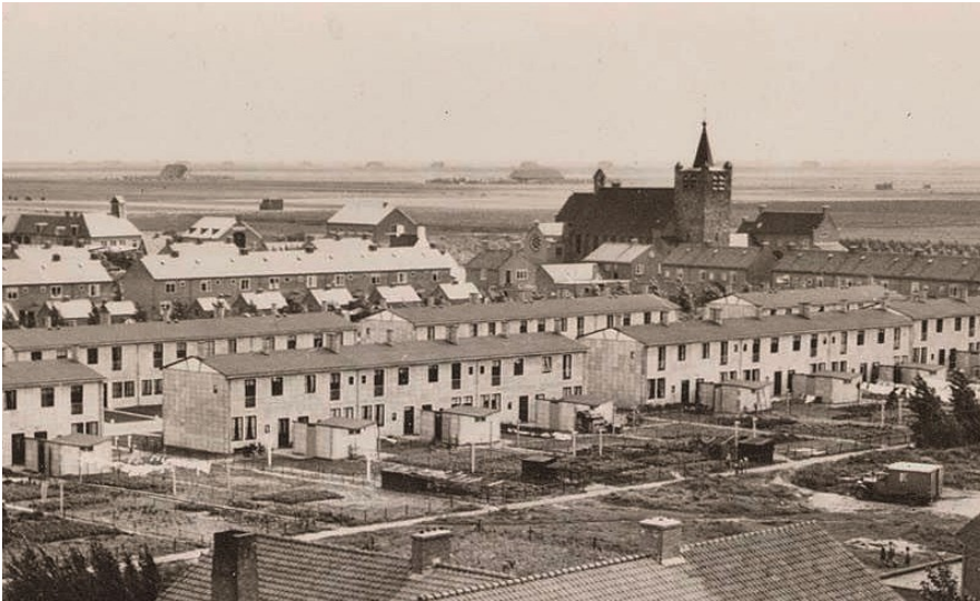
Airey-woningen aan de Patrijsstraat te Wieringerwerf, architect J.F. Berghoef. [collectie SteenhuisMeurs]
