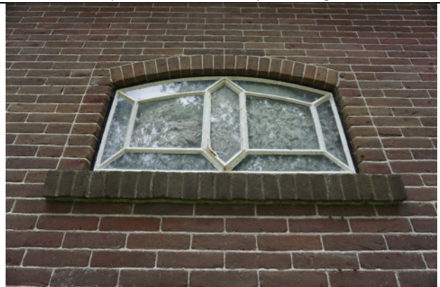
Stalraam in noordgevel
