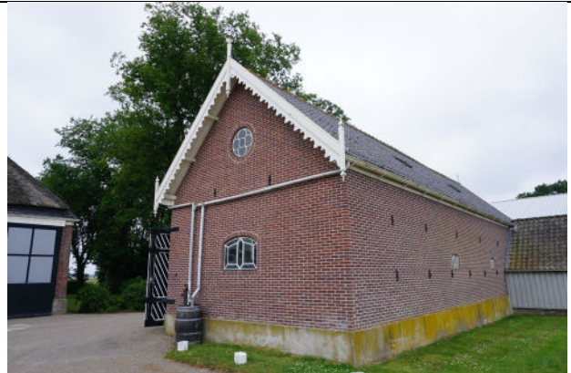
Zuidelijke kopgevel en oostgevel wagenschuur
