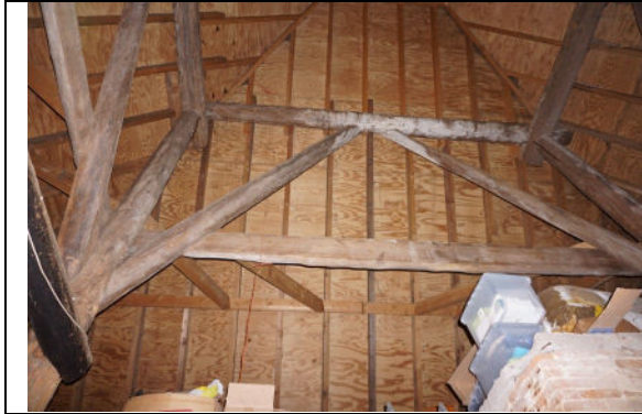
Deel van vierkantconstructie gebint
