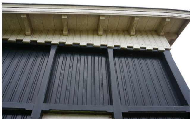
Detail houten daklijst
