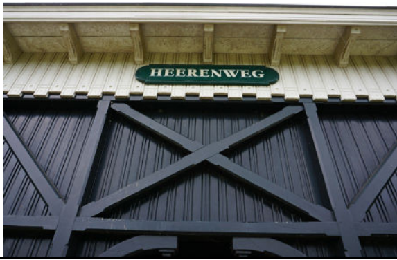
Bord met haltenaam aan voorgevel
