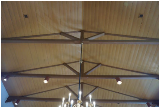
Zicht op deel van plafondconstructie
