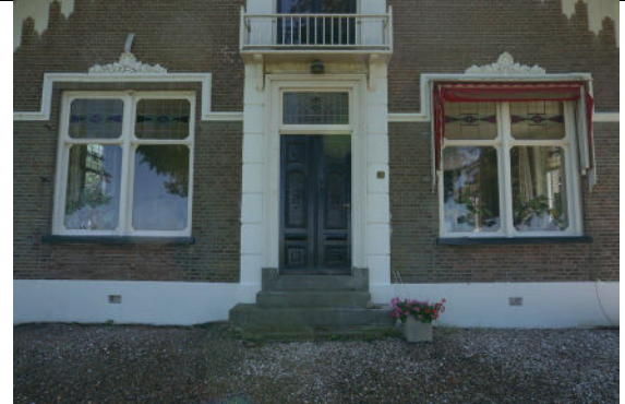
Entree in voorgevel
