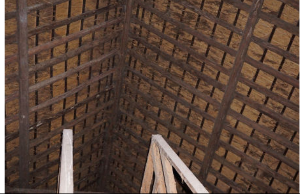
Deel van kap in bedrijfsgedeelte
